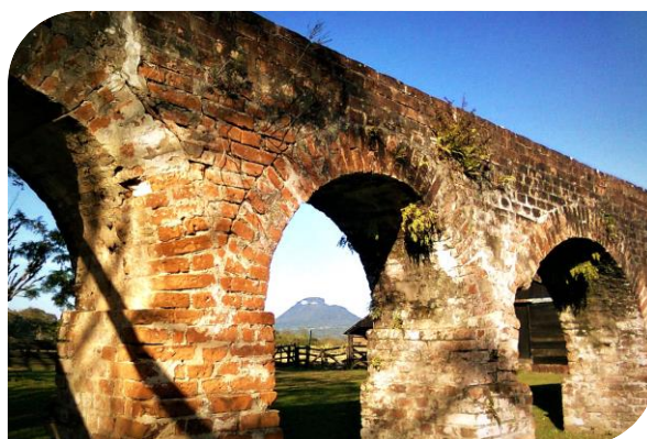
Figura 5 - Aqueduto de Candelária, com 304 metros de comprimento e 79 arcos, simetricamente distribuídos, provavelmente construído em 1870; ao fundo o Cerro do Botucarái, com 569,63m de altura em relação ao nível do mar, um dos mais altos morros isolados do estado. Foto: Acervo fotográfico do Departamento de Qualidade Ambiental da Fepam / RS.
