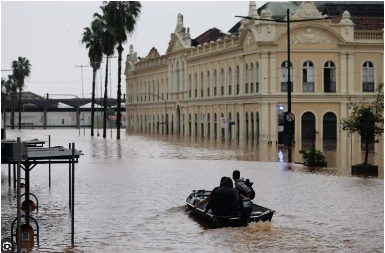
Figura 2. Enchente de maio de 2024. Avenida Borges de Medeiros e Mercado Público com o Muro da Avenida Mauá ao fundo, Porto Alegre. Fonte: Fotografia de Mateus Bruxel/Agência RBS.
