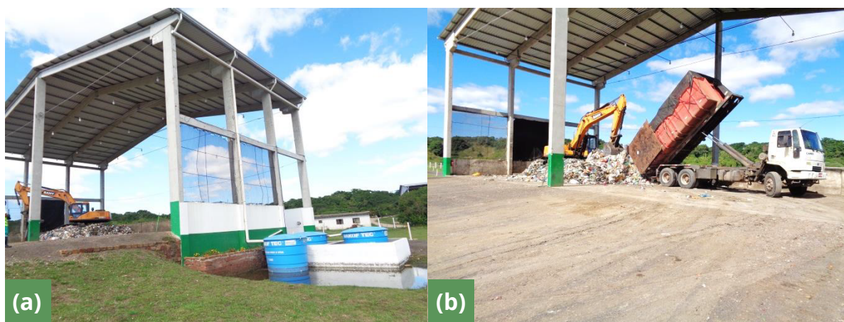
Figura 3. Estação de transbordo licenciada pela FEPAM no município de Boa Vista do Sul. (a) Tanque de armazenamento de efluente (chorume). (b) Piso impermeabilizado em toda a unidade.
