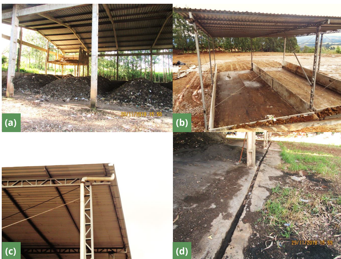
Figura 2. Unidades de Compostagem licenciadas pela FEPAM nos municípios de Nova Araçá e Paulo Bento, RS. (a) Telhado de cobertura. (b) Piso impermeabilizado. (c) Calhas para drenagem pluvial. (d) Canaletas para drenagem de chorume.
