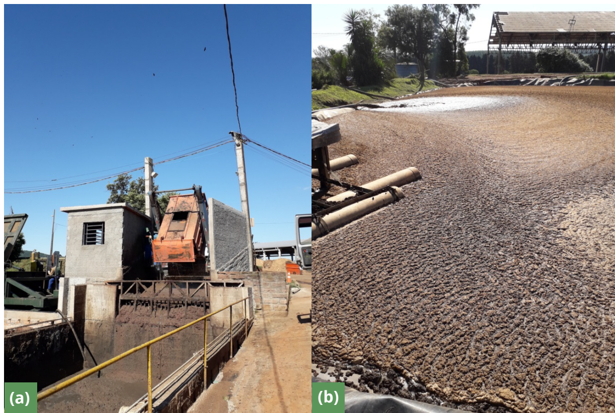
Figura 13. Central de Beneficiamento de Dejetos Líquidos licenciada pela FEPAM no município de Montenegro, RS. (a) Decantador. (b) Homogeneização dos dejetos.
