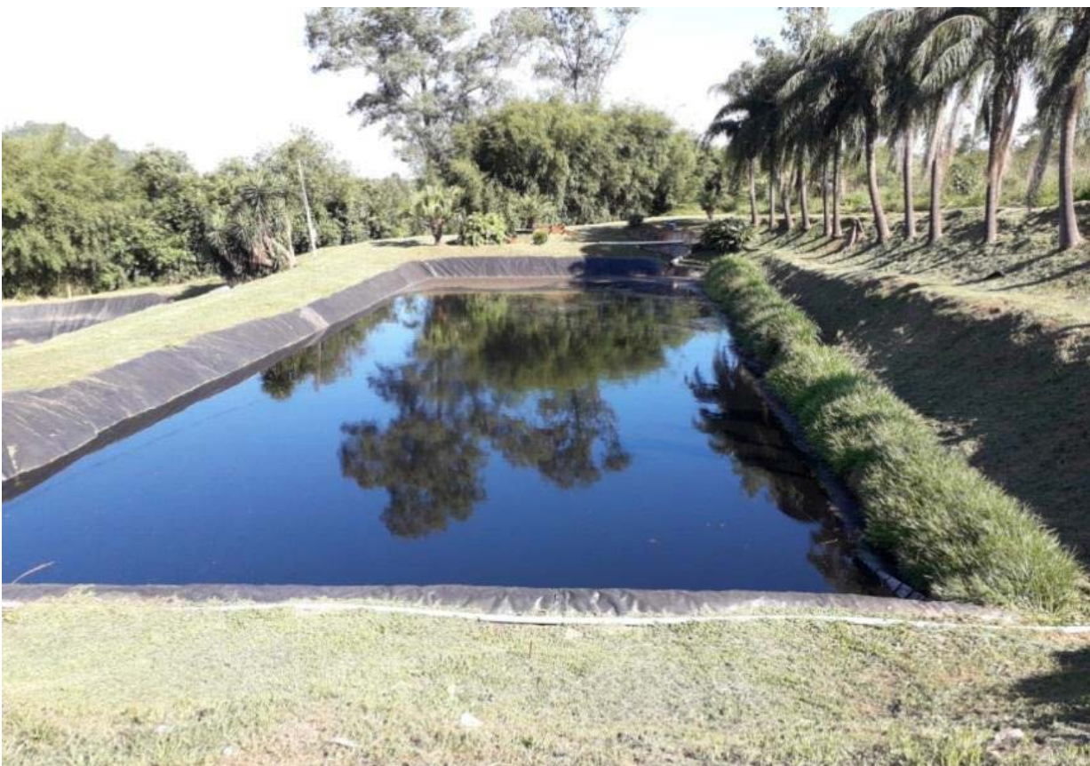
Figura 15. Lagoas anaeróbias.
