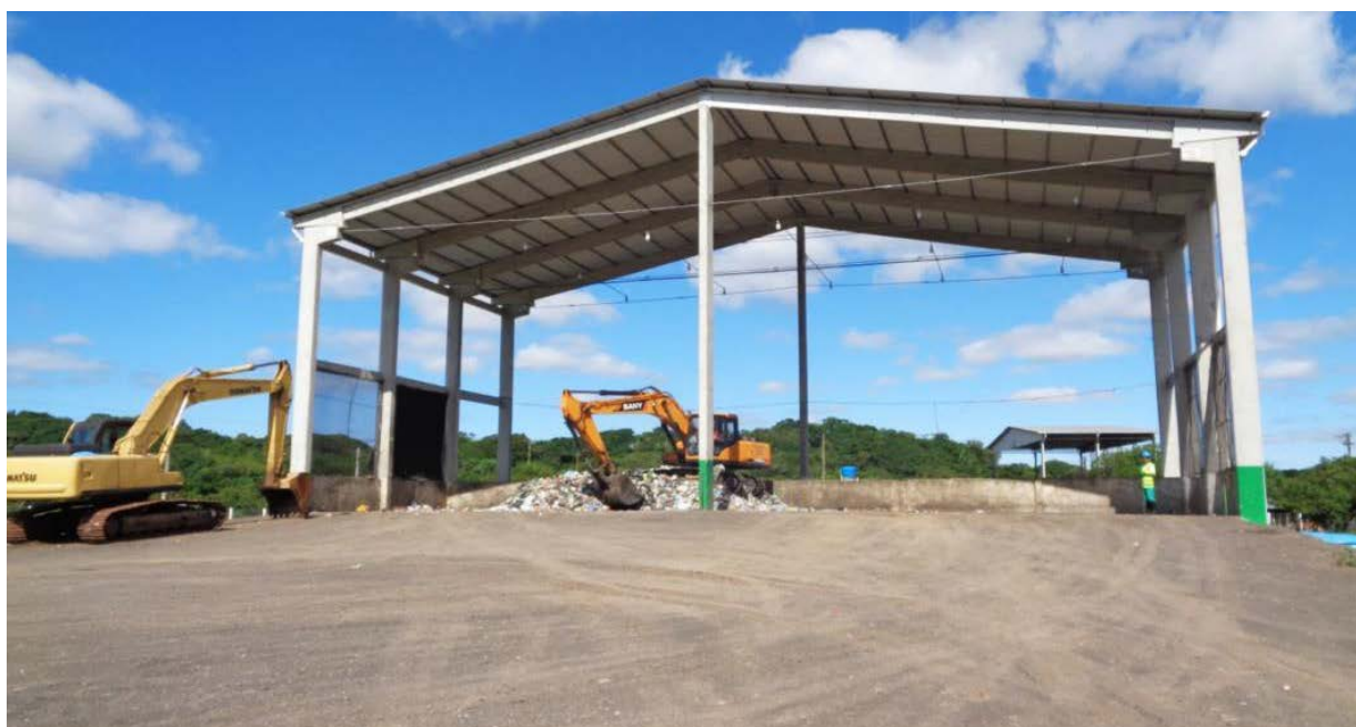
Figura 4. Estação de transbordo com telhado de cobertura.
