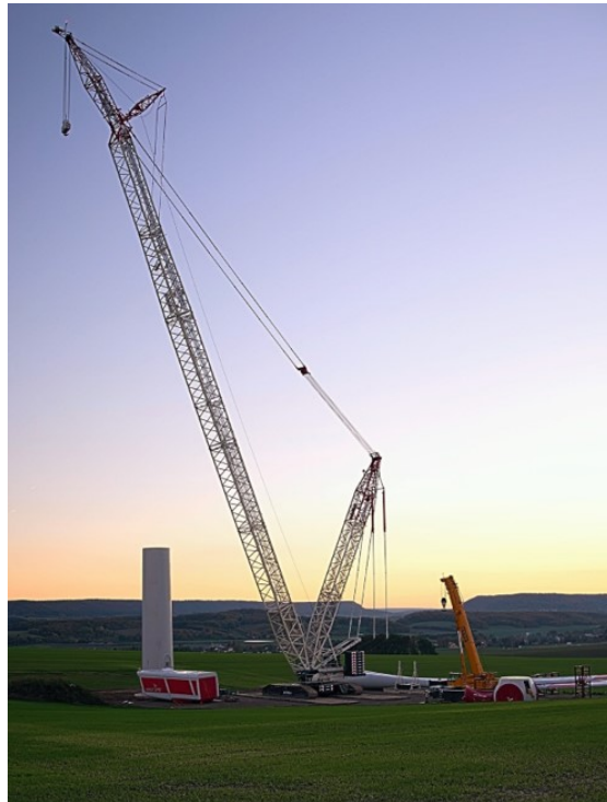
Figura 6.1.: Montagem de um aerogerador ou turbina eólica. Fonte: Pixabay.com
