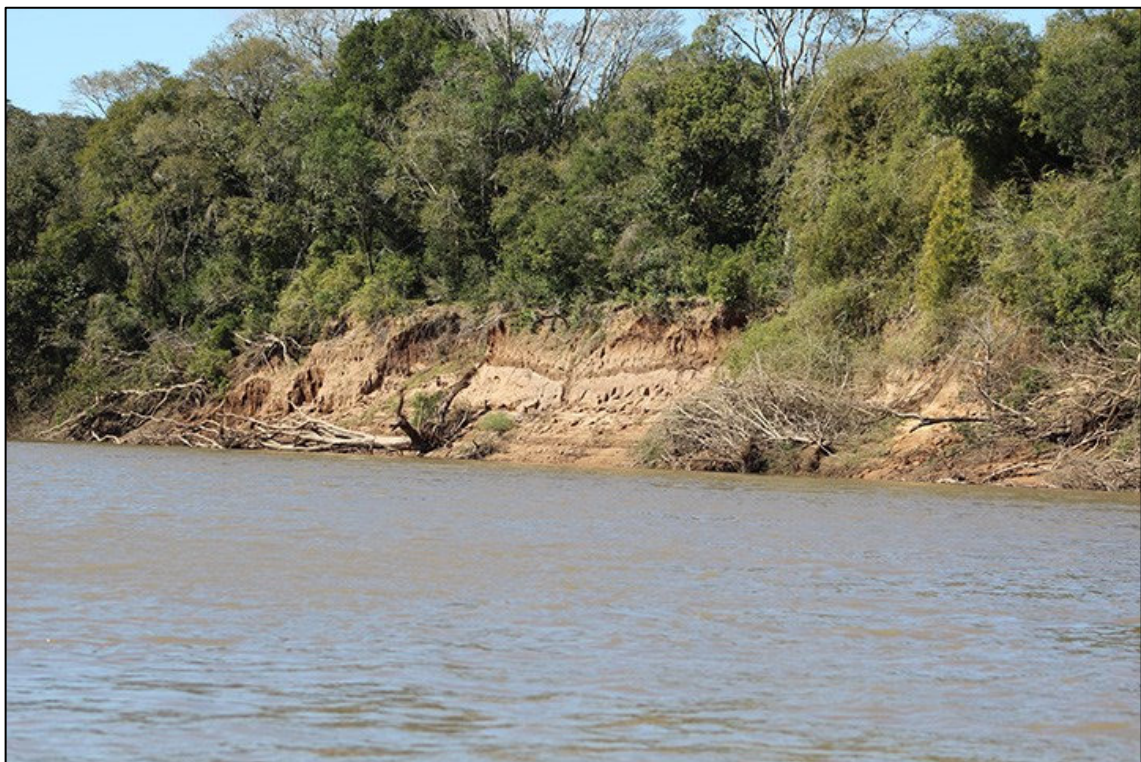
Figura 4.8 – Margem esquerda, margem côncava e erosiva, com princípio de erosão (Ponto 112).
