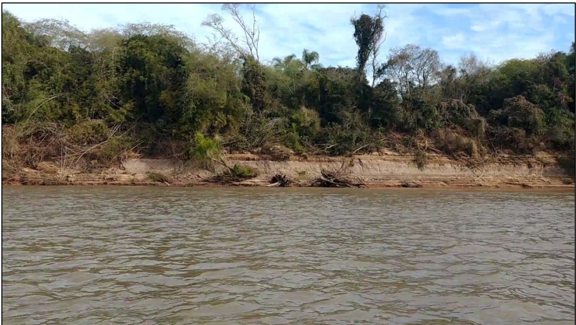
Figura 4.12 – Rocha siltítica exposta na margem direita, na base do talude, e princípio de erosão (ponto 197).
