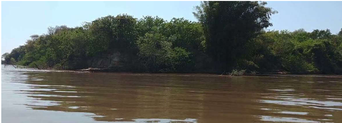
Figura 3.279 – Vista do ponto 281, ponta sudoeste da Ilha das Flores, onde se observa o desmoronamento do talude de planossolo.
