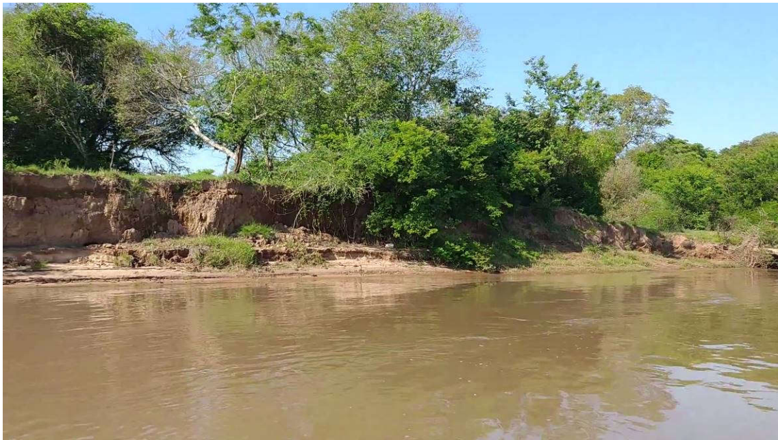
Figura 3.275 - Ponto 279, margem direita, talude de planossolo com 1,5 metros de altura com processo erosivo.
