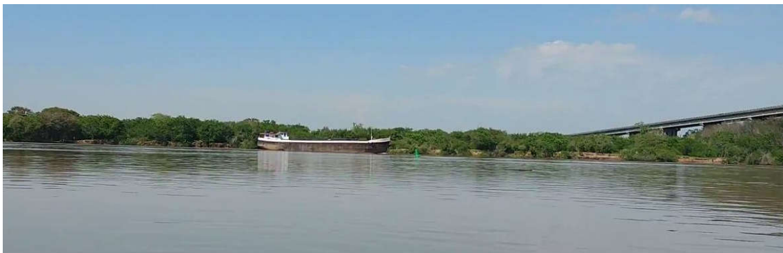
Figura 3.277 – Ponto 280, observando a margem direita logo a jusante da ponte de São Jerônimo e General Câmara.
