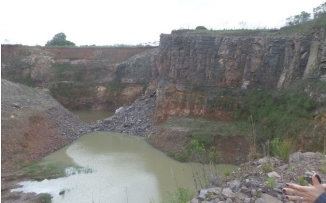
Figura 3 - Talude com inclinação de 90° e deposição de água meteórica (29°05'10.24"S, 53°26'48.60"O). Data: 17/12/2015
